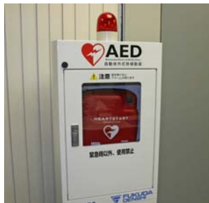
主要店舗に設置したAED
