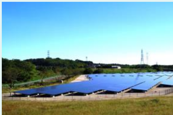
●『太陽のチカラ』取組みによるお客さまの発電事業施設
