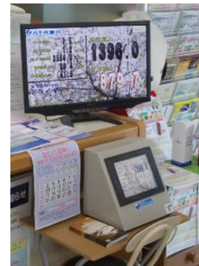
調光機能付き直流給電式LED照明システム
